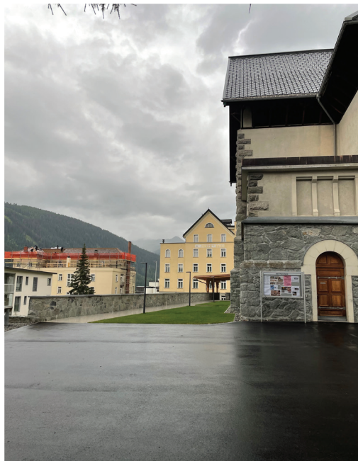
Parkplatz bei Marienkirche
